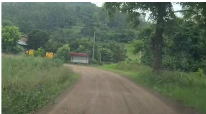
Foto 20: Vista geral do trecho - Estaca 2+600
