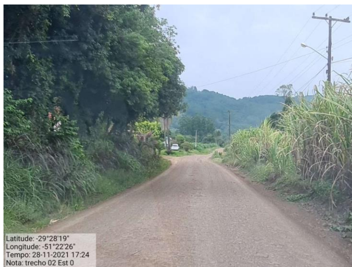
Foto 1: Início do trecho - Estaca 0+700
