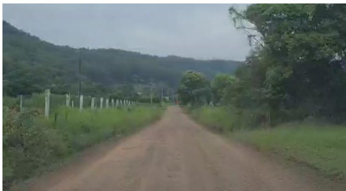
Foto 12: Vista geral do trecho – Estaca 1+800
