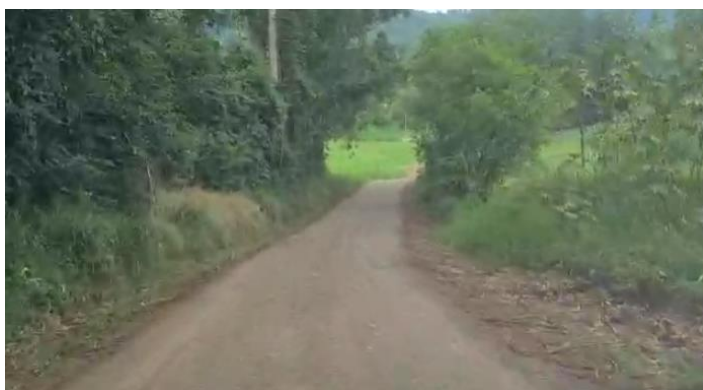
Foto 7: Vista geral do trecho - Estaca 1+300
