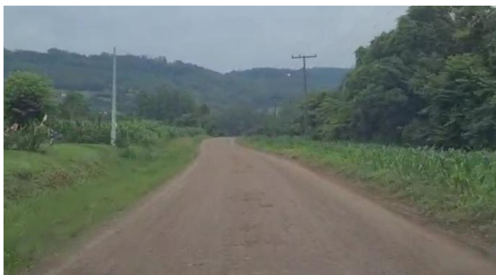
Foto 2: Vista geral do trecho - Estaca 0+800
