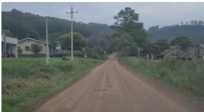
Foto 15: Vista geral do trecho - Estaca 2+100
