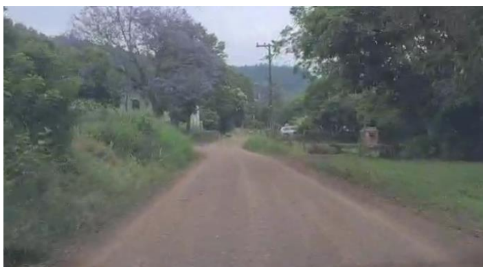
Foto 16: Vista geral do trecho - Estaca 2+200
