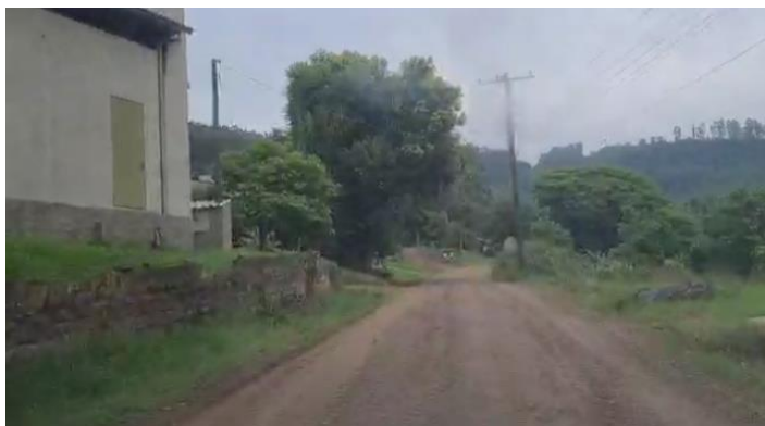
Foto 17: Vista geral do trecho - Estaca 2+300
