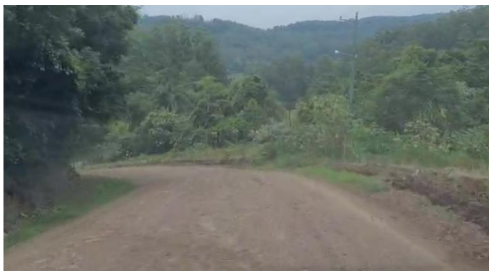
Foto 4: Vista geral do trecho - Estaca 1+000m
