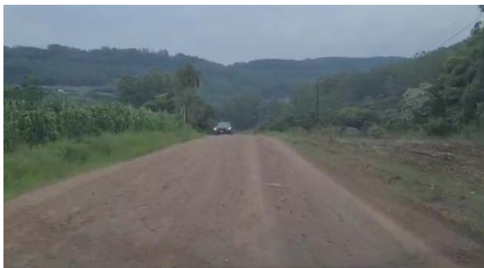
Foto 3: Vista geral do trecho - Estaca 0+900
