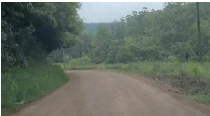
Foto 6: Vista geral do trecho – Estaca 1+200
