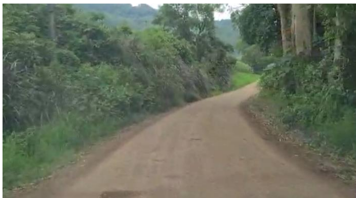
Foto 10: Vista geral do trecho - Estaca 1+600
