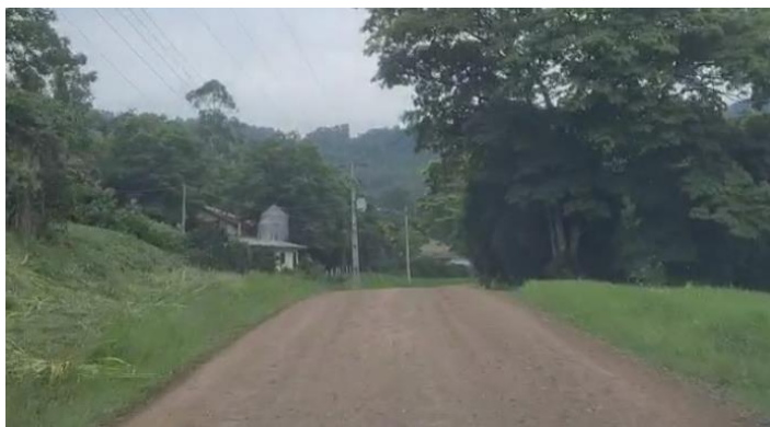
Foto 18: Vista geral do trecho - Estaca 2+400
