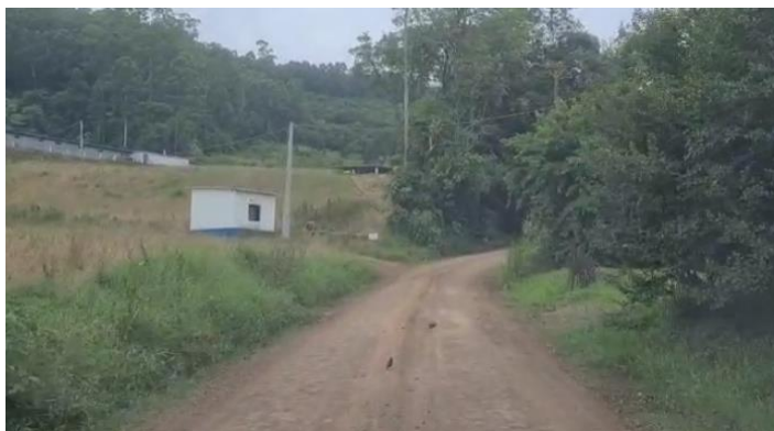
Foto 21: Final do trecho - Estaca 2+700
