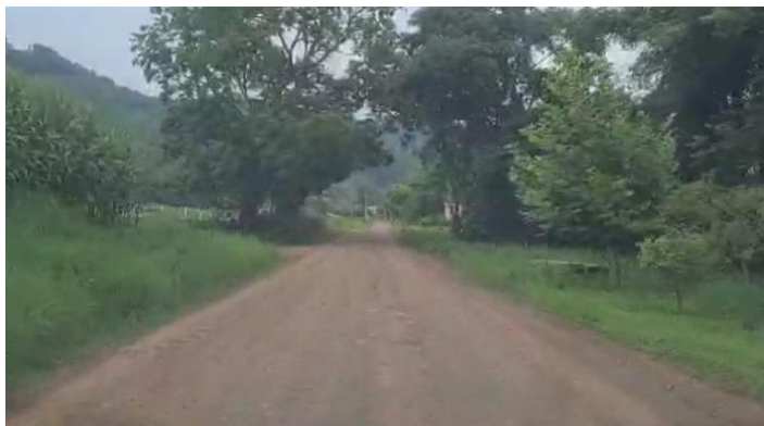
Foto 11: Vista geral do trecho - Estaca 1+700
