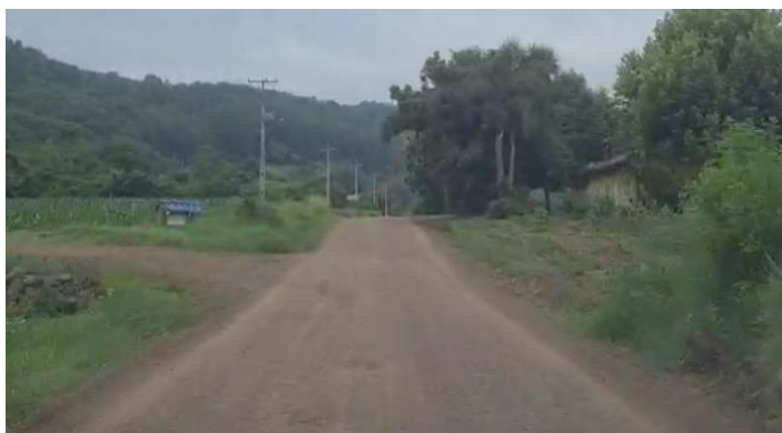
Foto 13: Vista geral do trecho - Estaca 1+900
