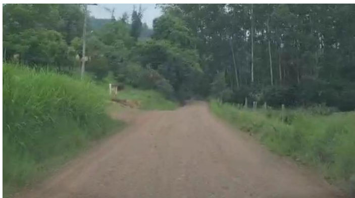
Foto 9: Vista geral do trecho - Estaca 1+500
