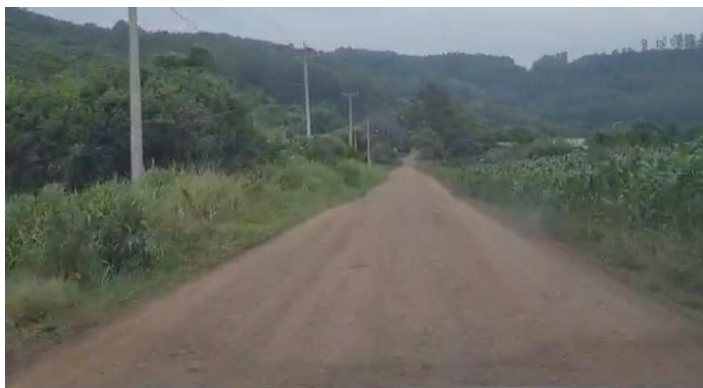
Foto 14: Vista geral do trecho - Estaca 2+000
