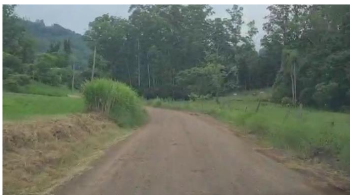
Foto 8: Vista geral do trecho - Estaca 1+400
